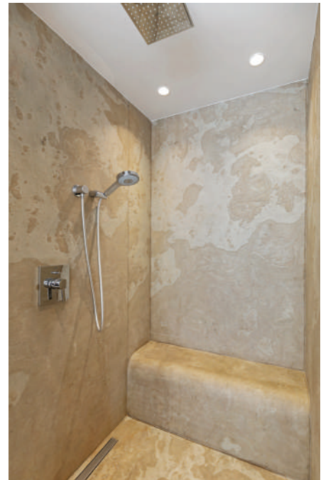
Pour ce projet, Flora Auvray a choisi de faire poser des feuilles de pierre de 1 mm d'épaisseur.
